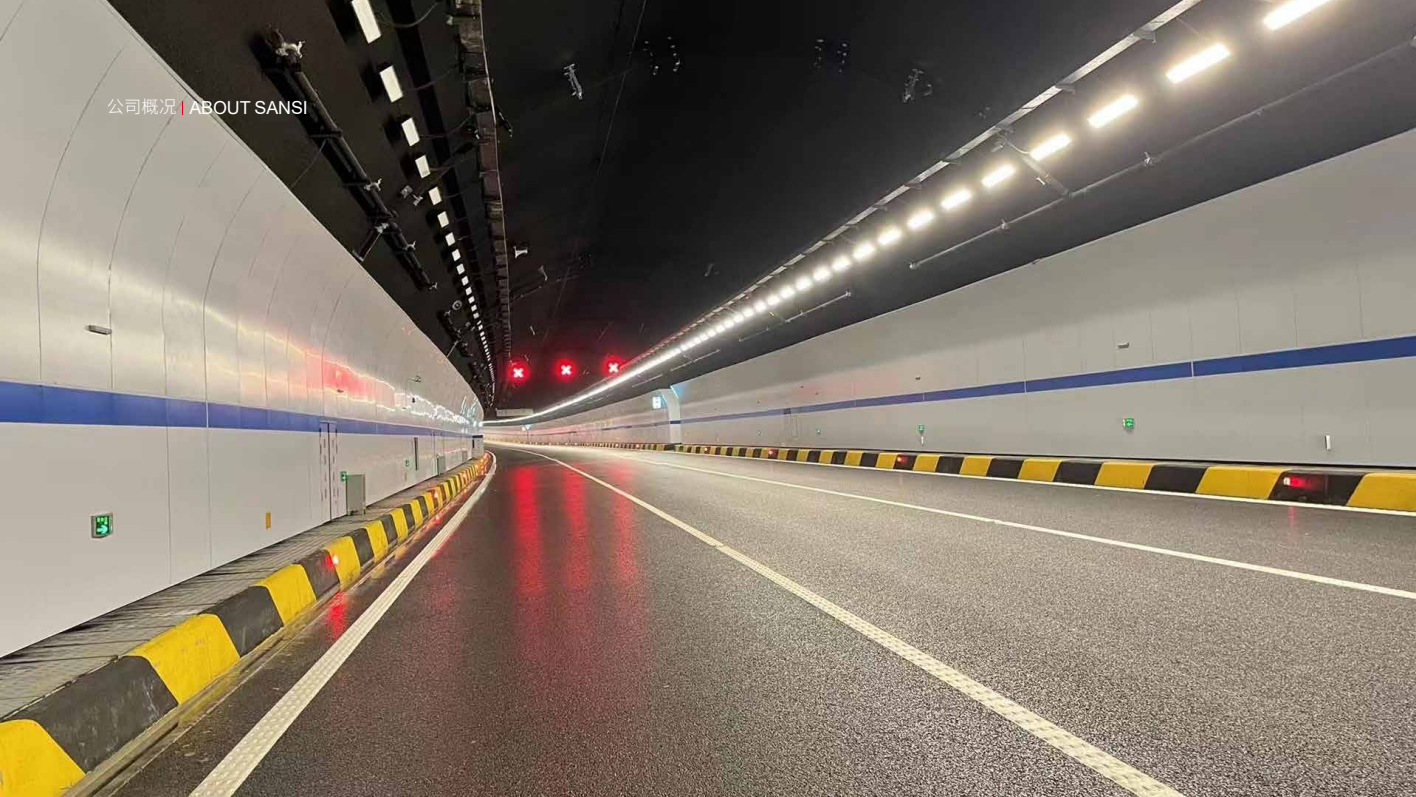
图3：厦门海沧隧道照明
