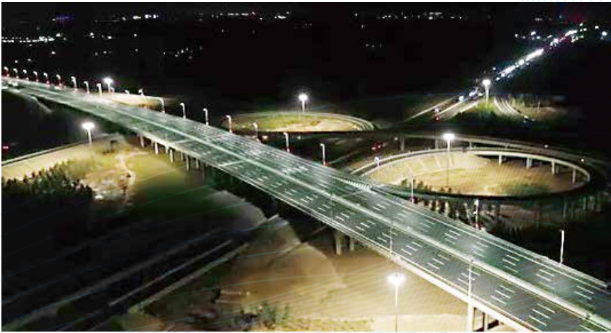
图5：京雄高速河北段智慧路灯
