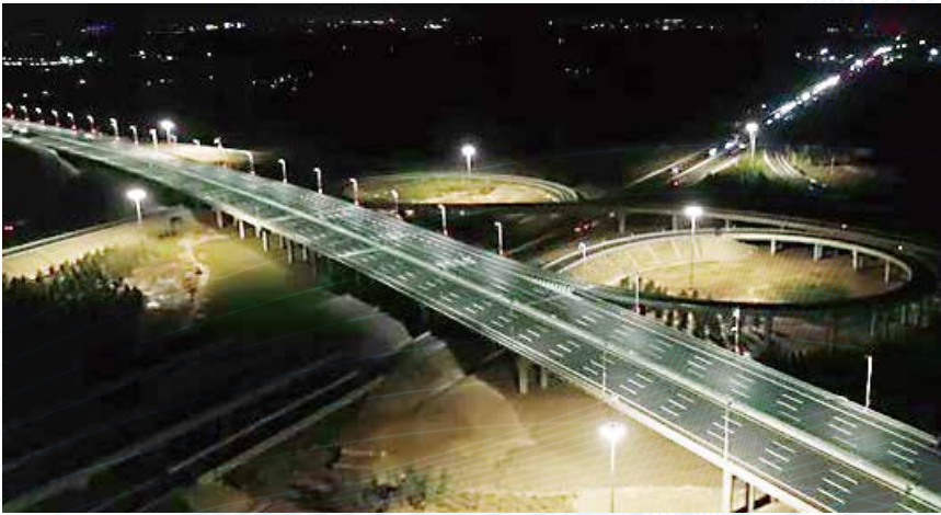
图5：京雄高速河北段智慧路灯
